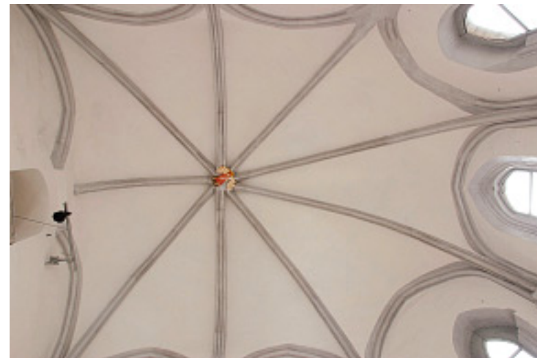
Rippengewölbe mit Schlussstein nach der Restaurierung
