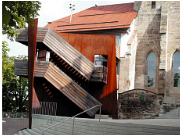
Die Fluchttreppe als freistehende Plastik aus gebogenem Cortenstahl
