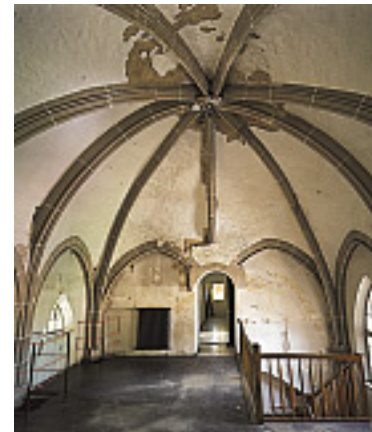
Zustand mit eingebautem Treppenhaus vor der Restaurierung.
