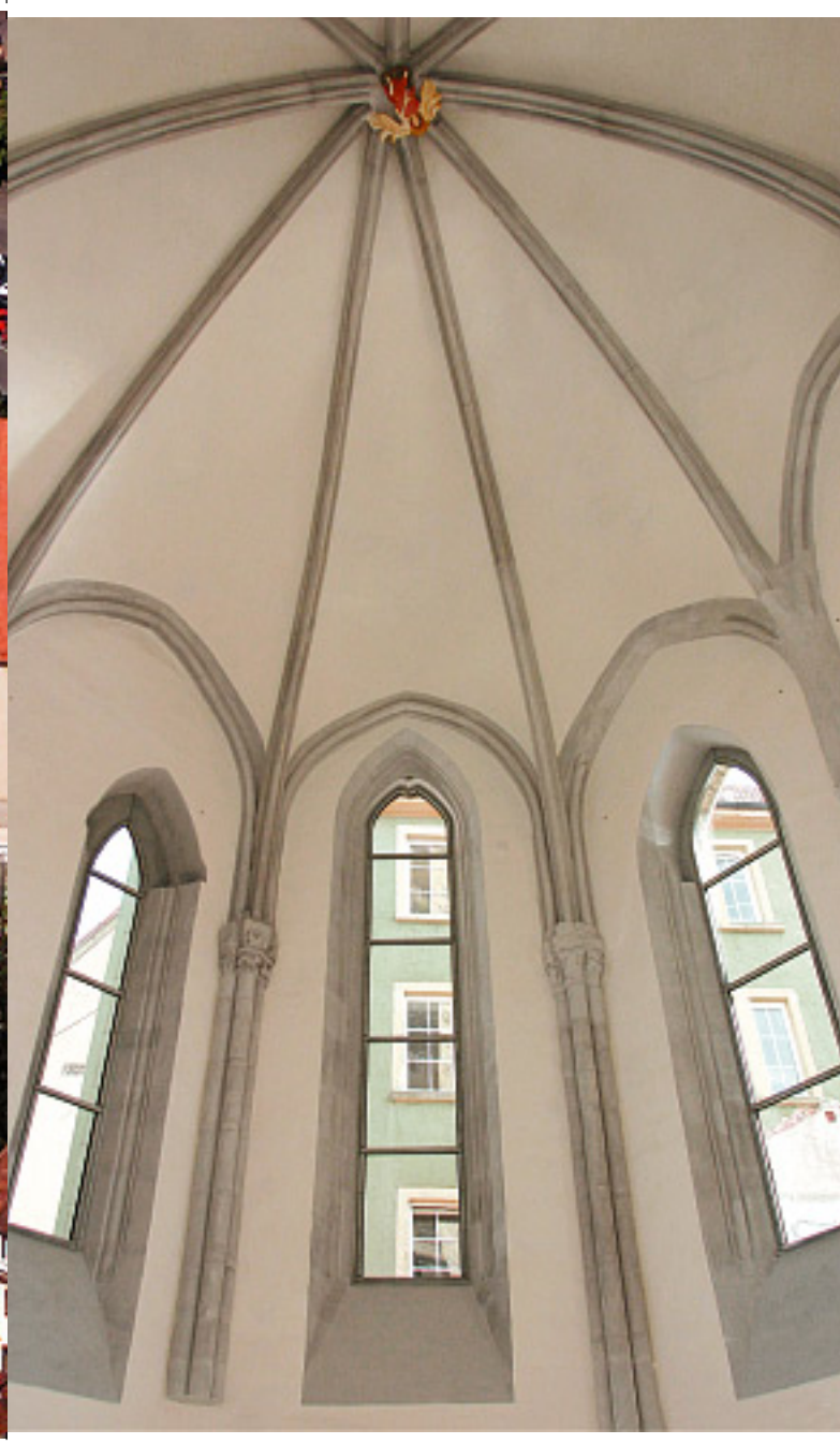
Gotischer Chor St. Michael im Backnanger Stadtturm
